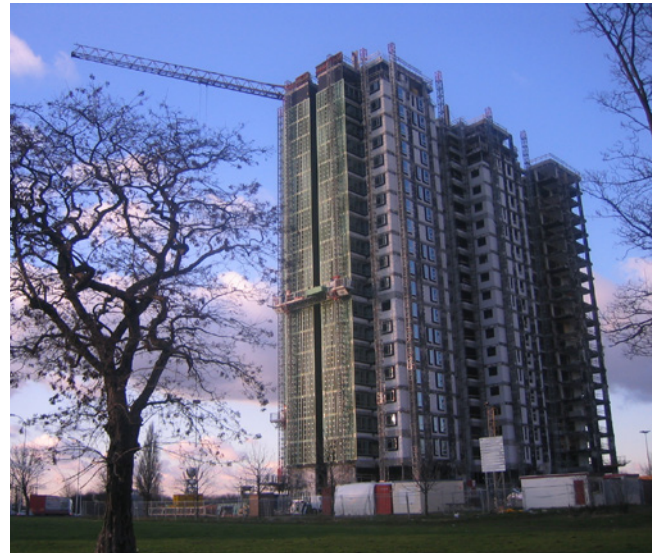
Renovatie van de Silvertopblokken
